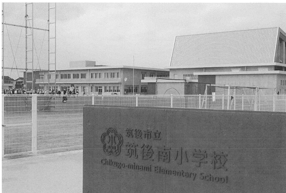
筑後南小学校 令和8年2月に全面完成
