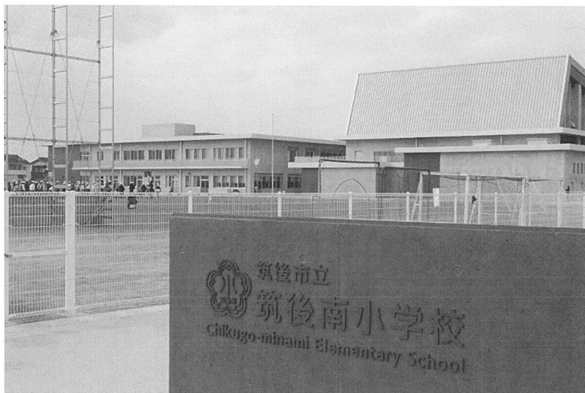
筑後南小学校 令和8年2月に全面完成
