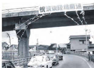
筑後陸橋(ループ橋)が開通
