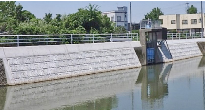
▲堤防高上げと護岸改修などの治水対策を実施した倉目川
