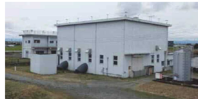
山ノ井〔下流〕排水機場
