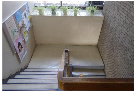
【エレベーターがなく階段のみの本庁舎】
