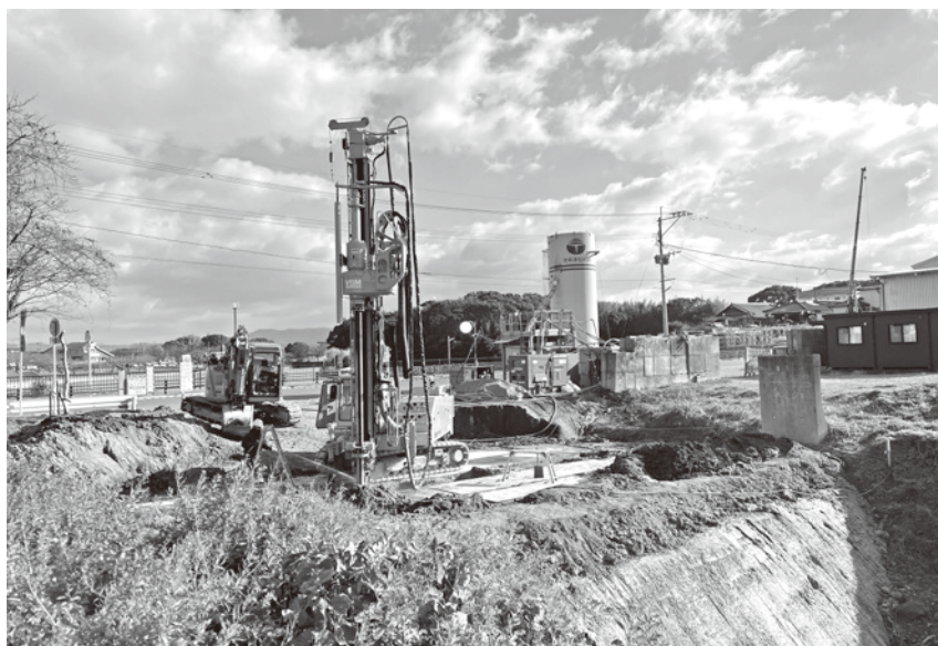
耐震工事が進む井原堤ため池
