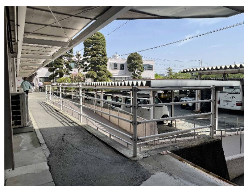
雨を防げない外部の移動空間
