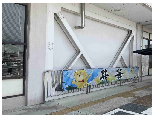
耐震補強のための筋交い
