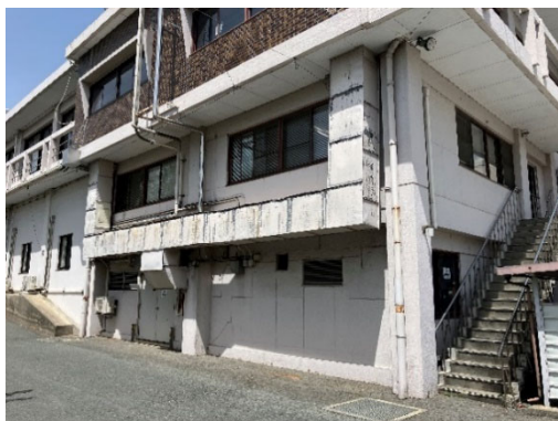
敷地の低い場所にある機械室
