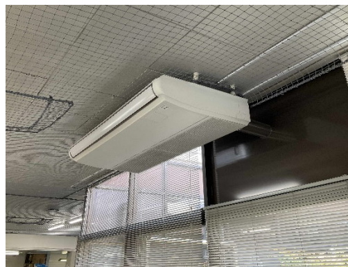
改修した空調機器
