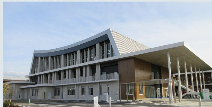
完成間近の体育館棟(1階 筑後南コミュニティセンター)
