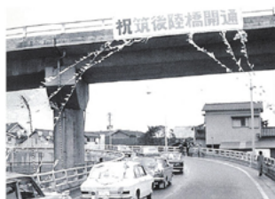
筑後陸橋(ループ橋)が開通
