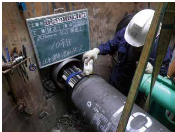
公共下水道管渠布設工事
