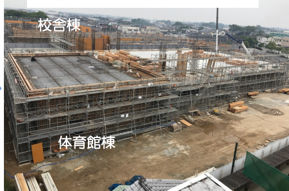
R5年6月：水田小学校校舎屋上から撮影
