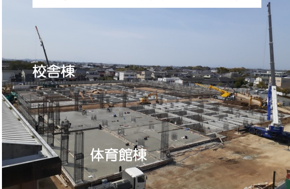
R5年3月：水田小学校校舎屋上から撮影
