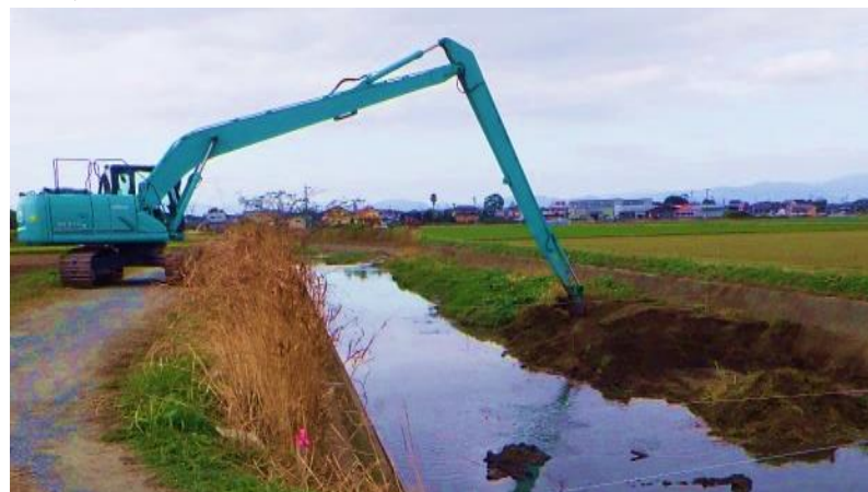
< 緊急浚渫事業 >
