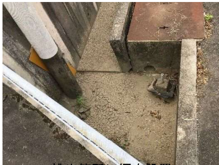
排出箇所に堰を設置
