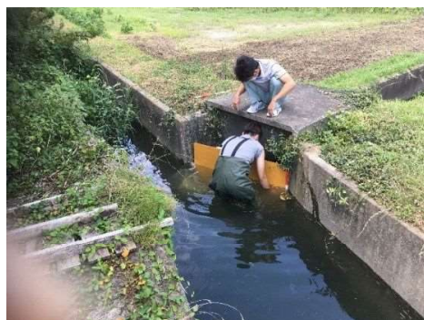
高い堰板の設置
