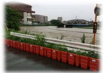
止水板の設置(令和2年7月豪雨)
