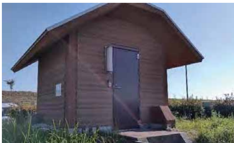
▲防水扉に改修した取水施設（6号井）
