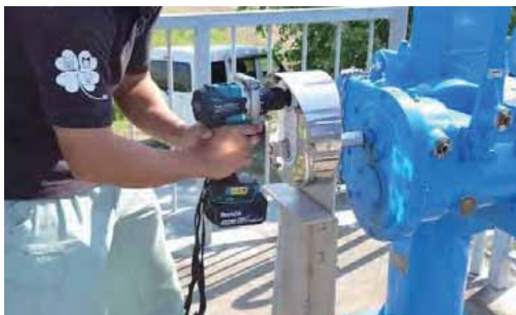
▲動力化後の水門操作（電動工具による操作）
