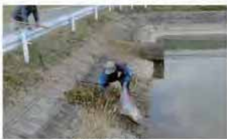
▲クリークの法面の清掃
