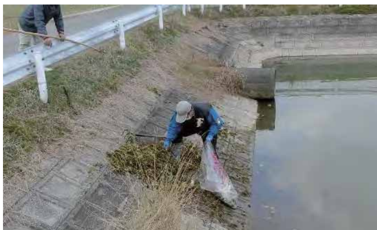
▲クリークの法面の清掃
