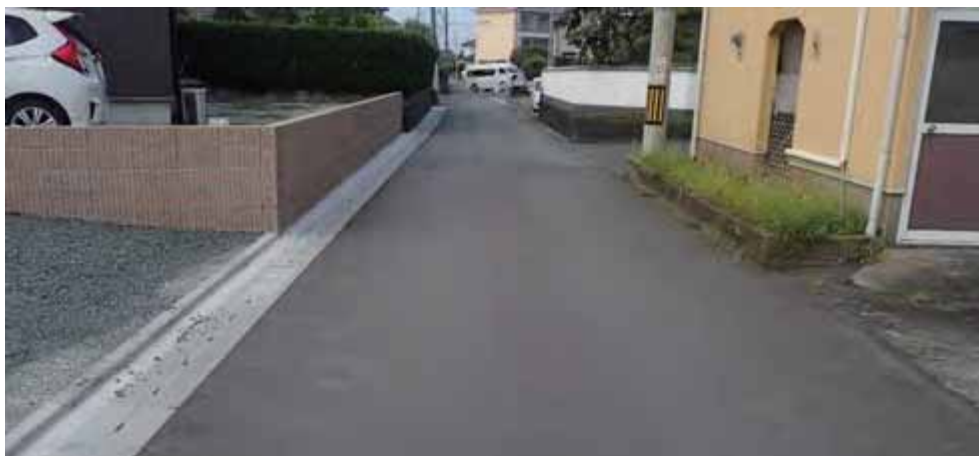
▲側溝の整備による道路冠水の防止
