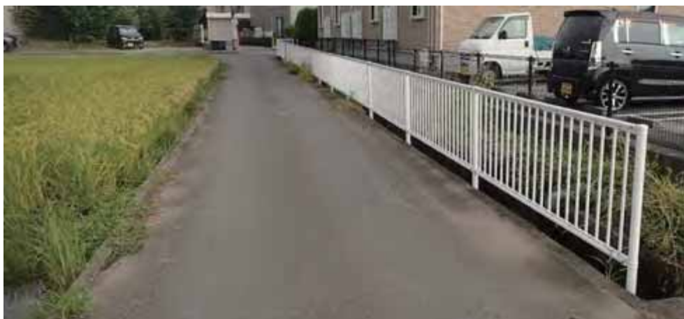
▲転落防止柵の設置による歩行者の転落防止
