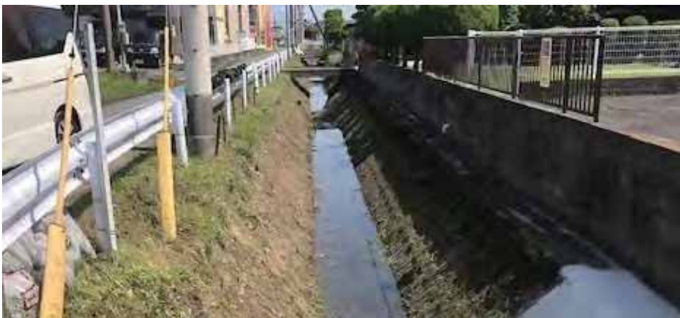
▲堆積泥土の浚渫と清掃作業後
