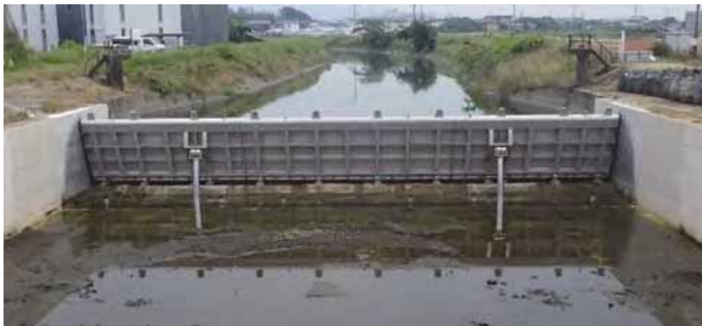
▲改修が進む富重堰（工事の様子）
