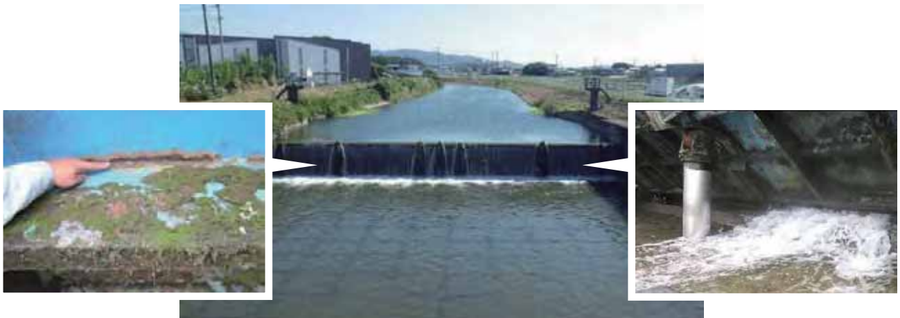
▲老朽化による腐食により漏水している富重堰
