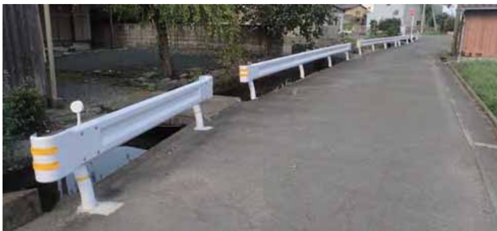
▲ガードレールの設置による車両の転落防止
