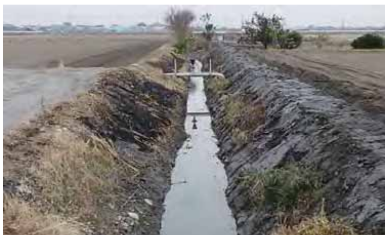
▲バックホウで堆積土を浚渫した後
