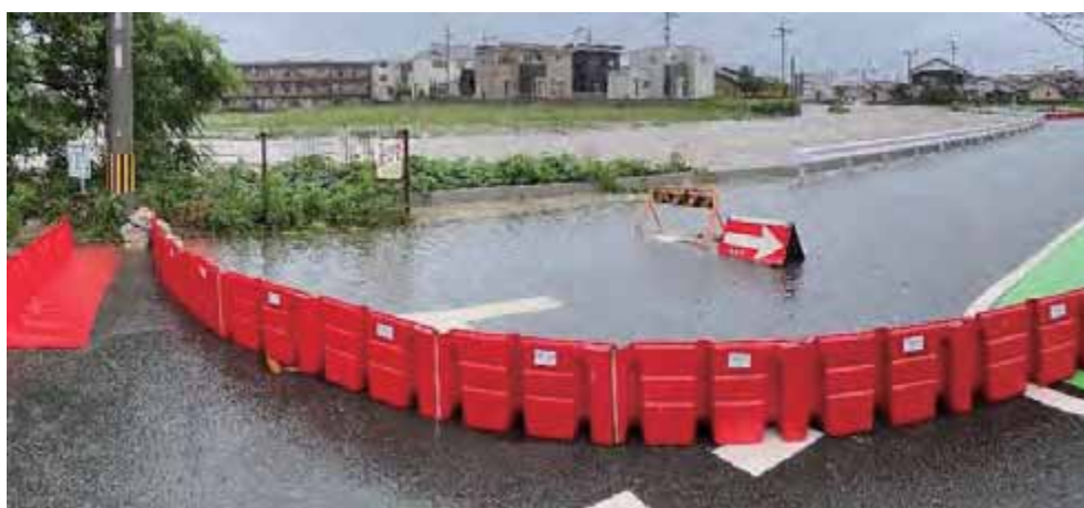
▲氾濫に備えて設置された止水板（市役所付近）
