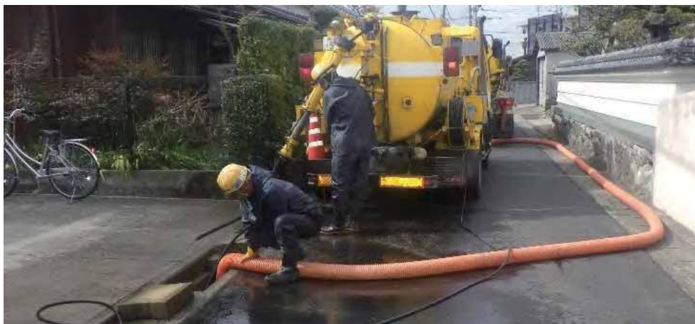
▲吸引車による道路側溝の浚渫作業
