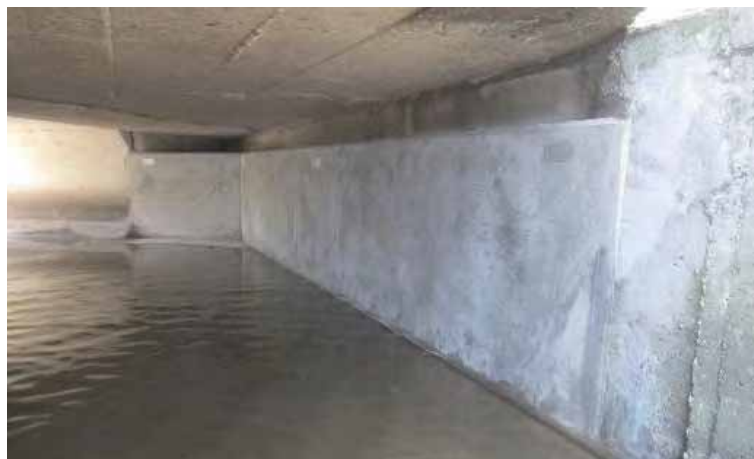
▲対策工事を実施した橋台
