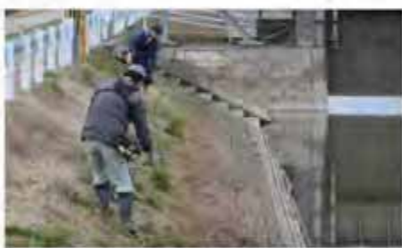
▲クリークの法面の草刈り
