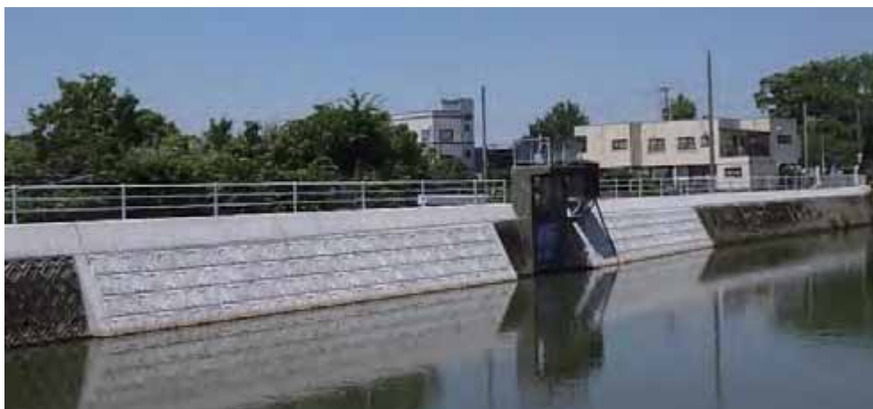
▲堤防嵩上げと護岸改修などの治水対策を実施した倉目川
