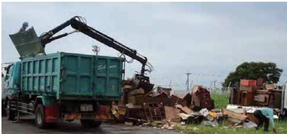
▲分別した災害廃棄物を積み込む様子
