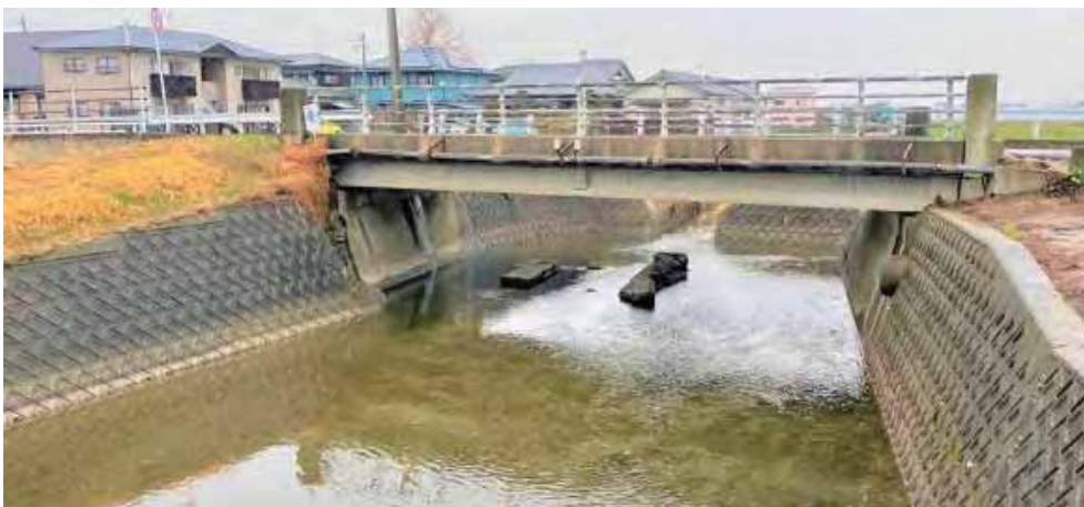
▲浚渫と樹木伐採を実施した後
