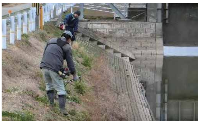
▲クリークの法面の草刈り
