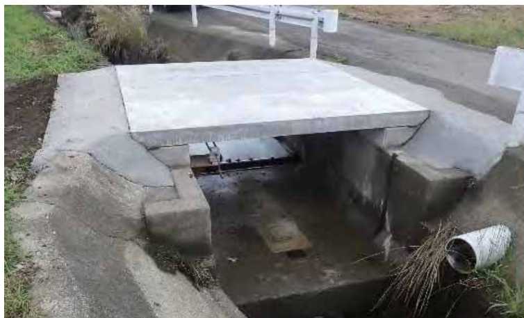
▲橋脚を撤去した改修後の農道
