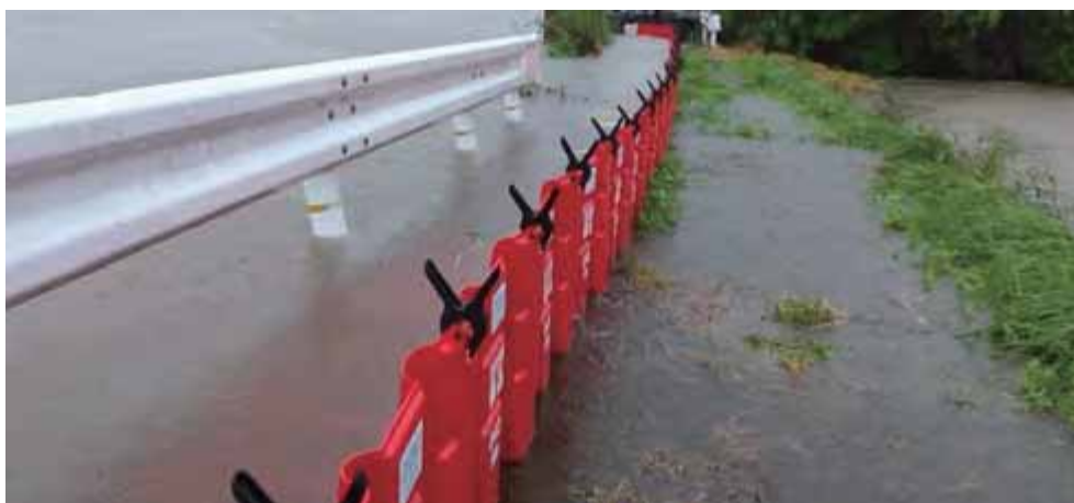
▲止水板により市営河川倉目川の氾濫を防止（西牟田地区）
