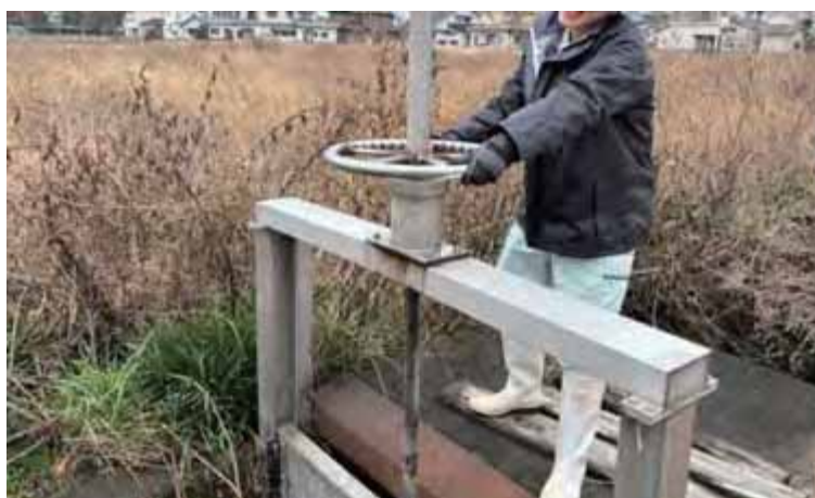
▲手動による水門操作
