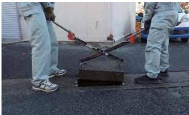
▲蓋上げ器による作業
