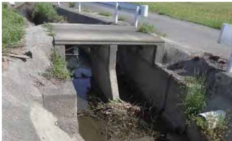
▲水路断面を阻害している農道の橋脚
