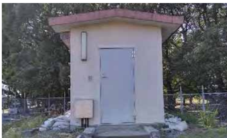
▲防水扉に改修した取水施設（4号井）
