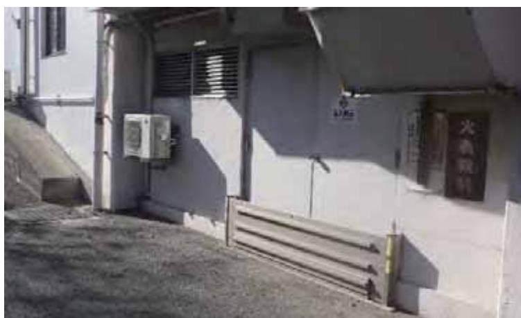
▲雨水の侵入を防ぐ止水板を設置
