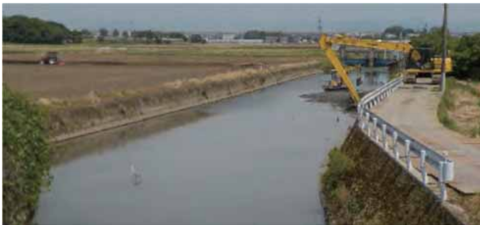
▲バックホウによる浚渫作業
