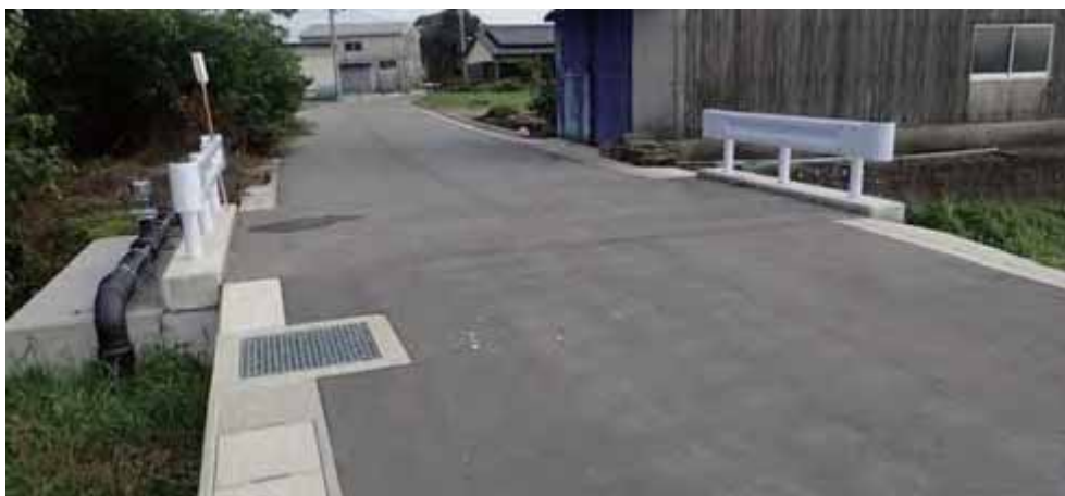
▲側溝の整備、道路橋の改修による道路冠水の防止
