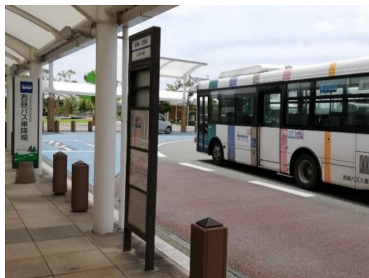
図 6-2 JR 筑後船小屋駅 駅前広場
