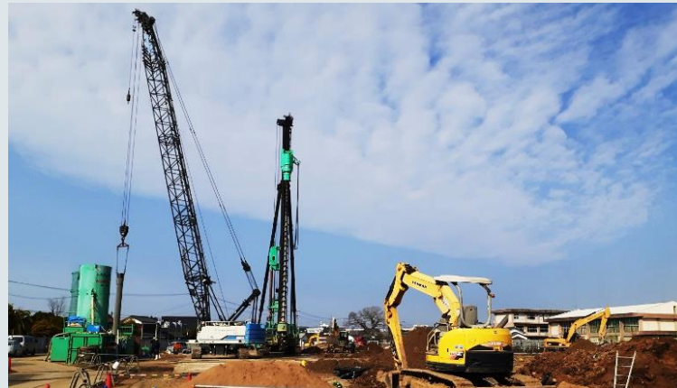
完成予想パース図（上）と建設工事の様子（下）
