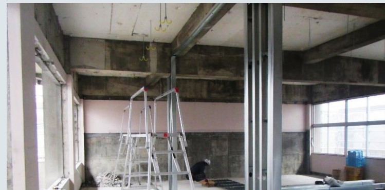
写真は筑後小長寿命化改修工事(R4年度)の様子
