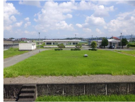
< 現在の北牟田配水場 >
