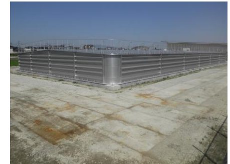
< 更新中の北牟田配水場 >
