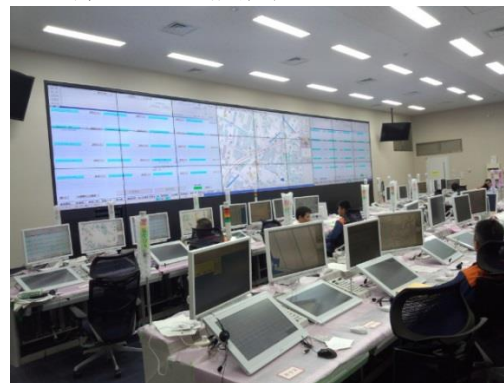
< 更新予定の通信指令センター >
