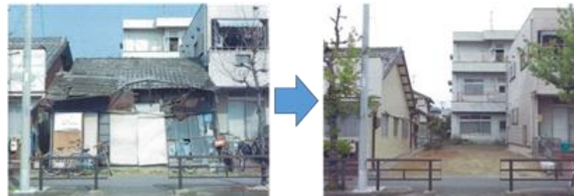
<老朽危険家屋等除却促進事業>
