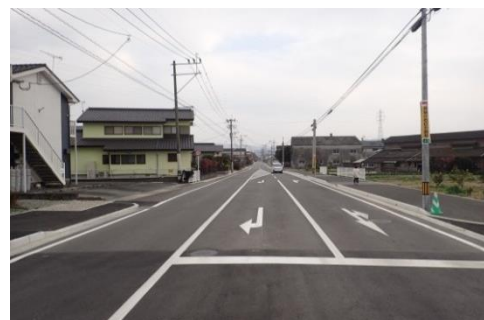
<整備後の道路>
