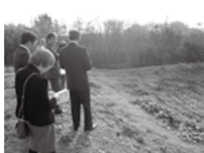
8月28日の豪雨で越水した倉目川堤防を視察する委員
