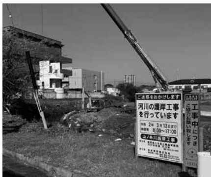
河川拡幅工事が始まった、サンコア東の山ノ井川
