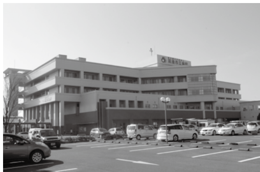
築21年が経過する筑後市立病院
