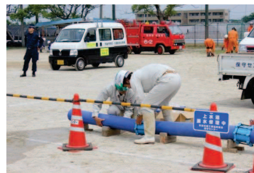
《水道管復旧訓練の様子》
