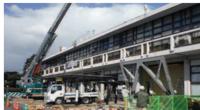
《耐震改修工事中の市役所本庁舎》
