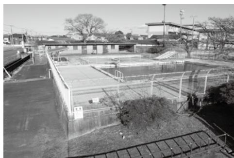
廃止されたままの水田コミュニティセンタープール
