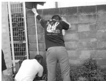
小学校のブロック塀調査の様子
