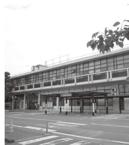
耐震工事を待つ市役所本庁舎
