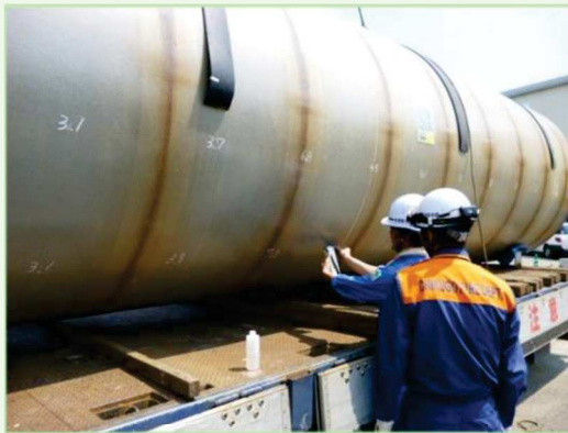
中間検査(地下タンク)
