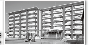
完成した市営住宅常用地▶
