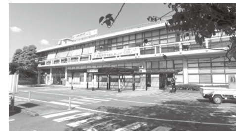
耐震改修工事を行う市役所本庁舎
