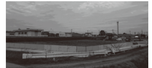
▲北牟田配水場更新事業(造成工事)
