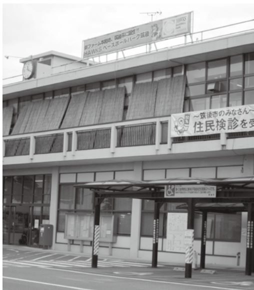
災害で本庁舎が全壊した場合は
