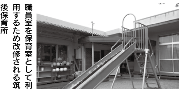
職員室を保育室として利用するため改修される筑後保育所
