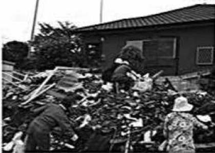
▲倒壊家屋の片づけを行うボランティア。
