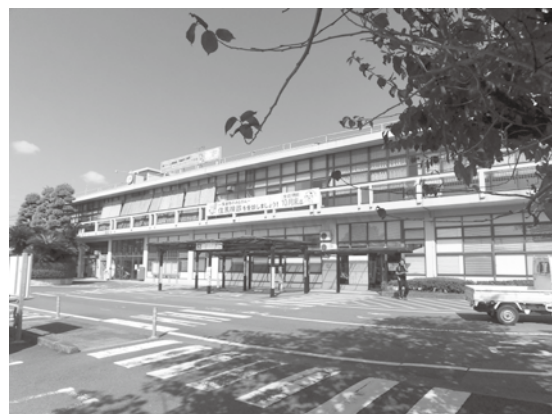
老朽化が進行している築60年の筑後市役所
