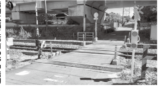
踏切拡幅工事前の野中踏切
