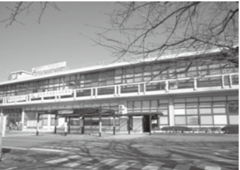
築60年が経過している市役所庁舎
