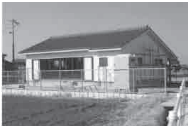
増築される松原小学校区学童保育所
