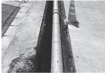
老朽管更新に伴う新管敷設
