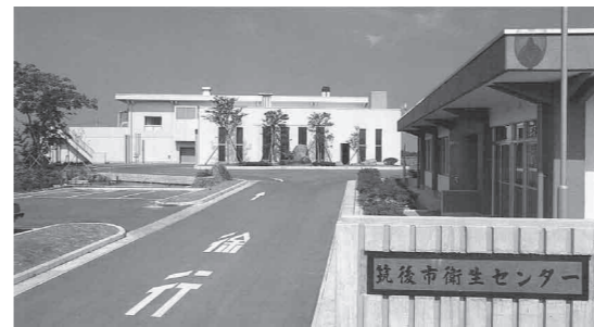
老朽化が進む衛生センター
