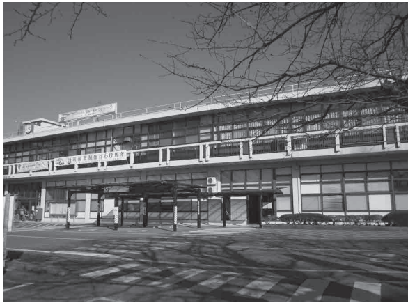
老朽化が進む築58年の市庁舎
