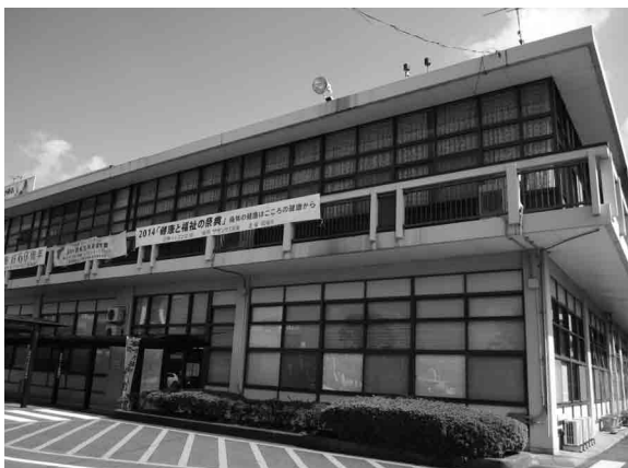
壁面の窓ガラス多使用など耐震構造に問題ある市庁舎
