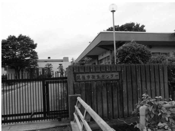
老朽化のため改修の必要な筑後市衛生センター
