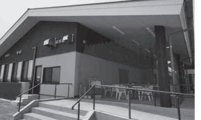
休憩室が増築となった「恋ぼたる」温泉館
