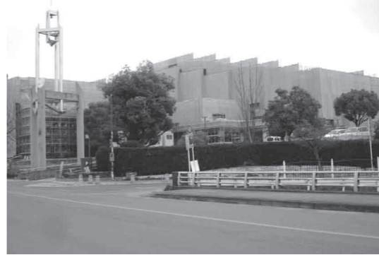
外壁工事中のサザンクス筑後
