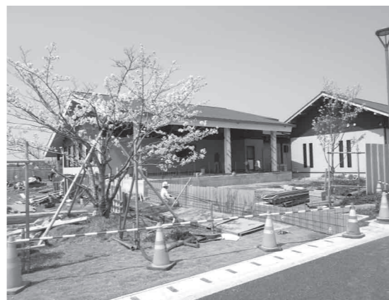
増設工事中の恋ぼたる温泉館休憩室
