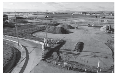
工事が進む筑後船小屋駅西側駐車場 奥はホークスファーム移転用地
