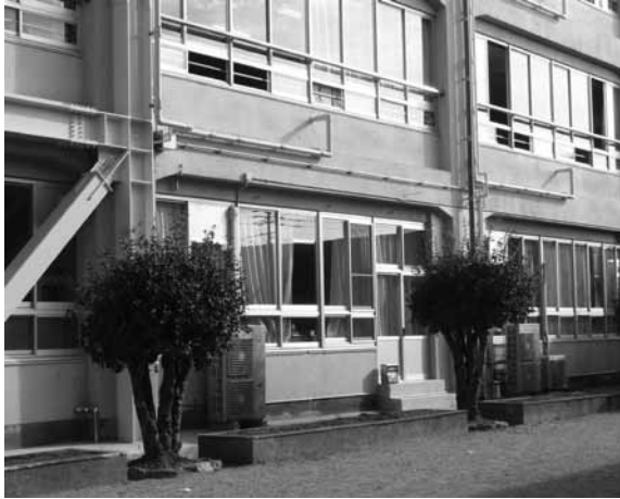
エアコン設置で快適な授業を行っている 八女市岡山小学校
