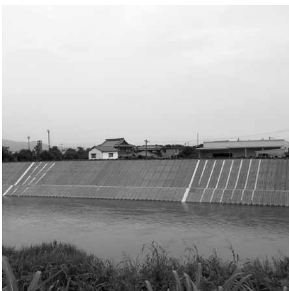
完成した沖端川護岸
