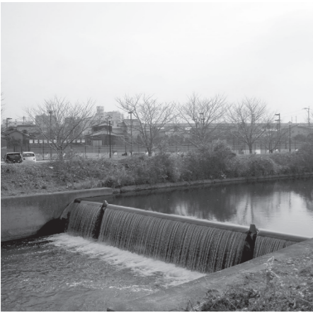
応急的に復旧される「若菜堰」
