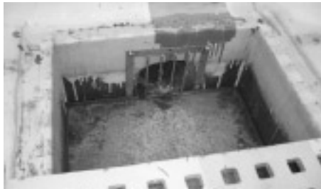
点検中の小学校プール排水口
