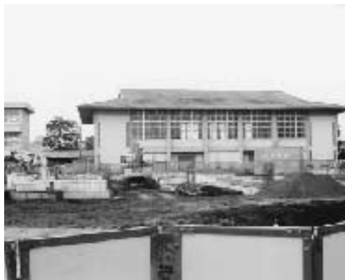
羽犬塚小学校体育館の建替え工事
