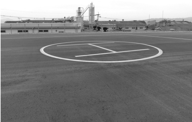
ヘリポートなどに整備された元産廃処分場
