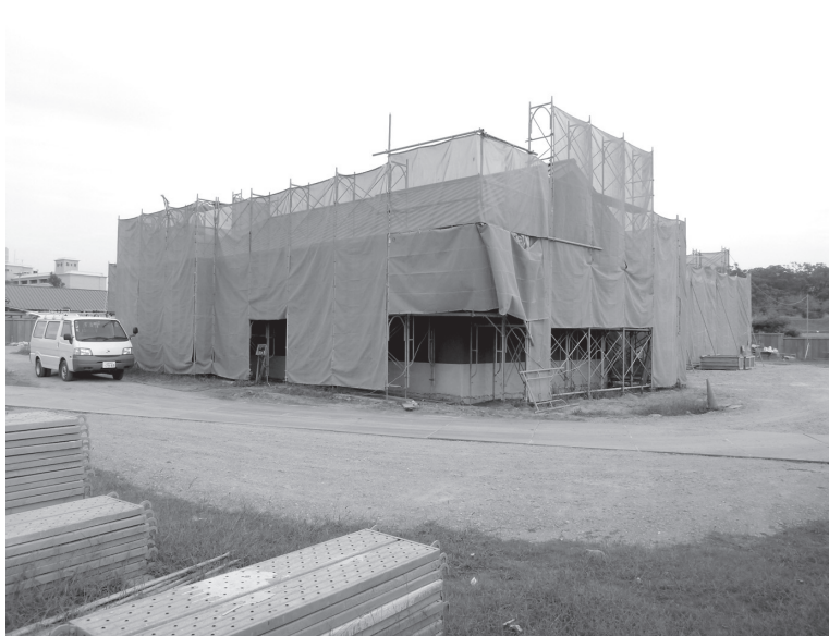
建て替え中の休憩施設「恋ぼたる」
